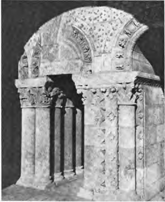
Fig. 45. — Groupement de colonnes et d'arcs supportant le mur de la salle capitulaire, aujourd'hui détruite, à l'ancienne abbaye de Saint-Aubin d'Angers.
